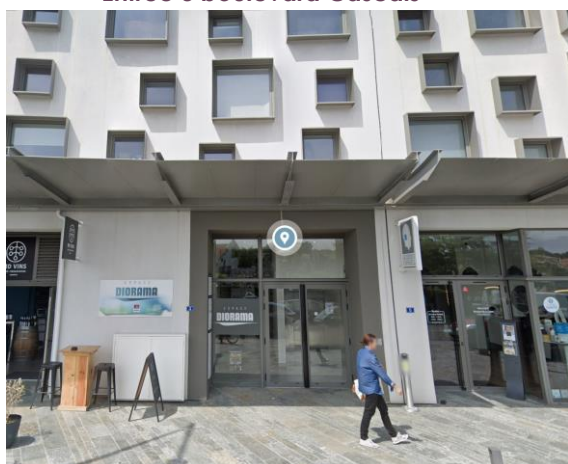
Entrée 3 boulevard Cascais
